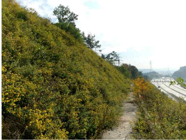
1소단 배수로 전경
